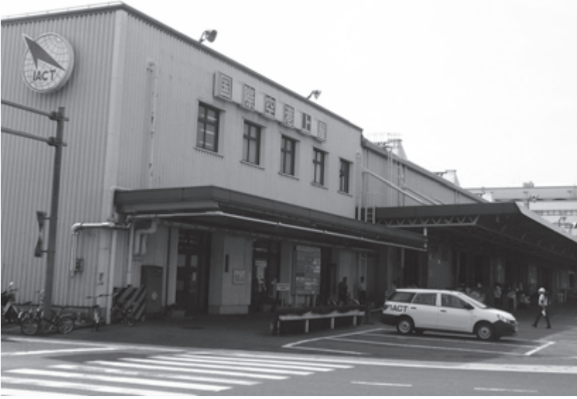
I A C Tは将来を見据えて新人事制度の導入を決めた（写真は成田空港貨物ターミナル地区の輸入共同上屋）
